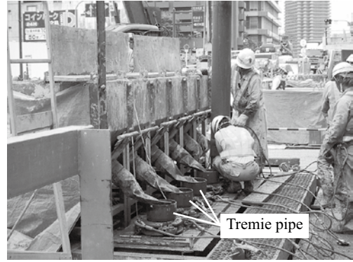
写真 3 コンクリート打設
