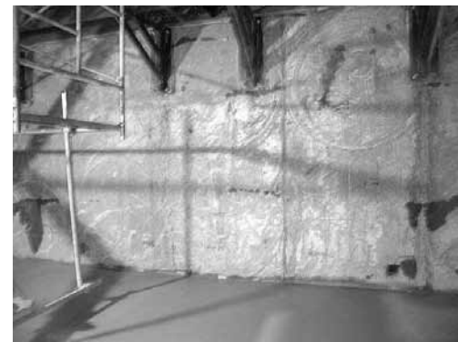
写真 4 壁体の仕上り状況 (GL: -16.0 m)
